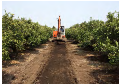
얇은 배수로 설치 등 표준과원 조성
